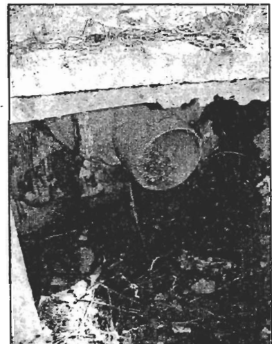
Pozzetto a monte della scarpata e tubazione (interno tombino) che vi confluisce da monte
